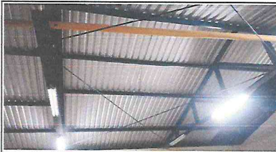
Foto 3: Se observa así desde el interior de la escuela el techo ya terminado.
