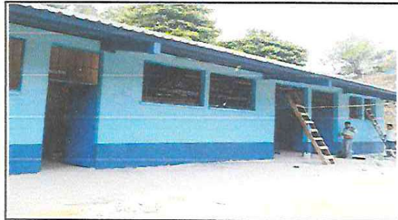
Foto 2: Se observa las ventanas nuevas y terminadas.
