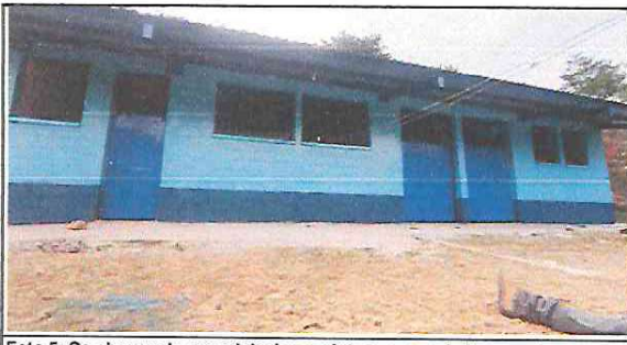
Foto 5: Se observa la remodelación o pintura nueva de la escuela.
