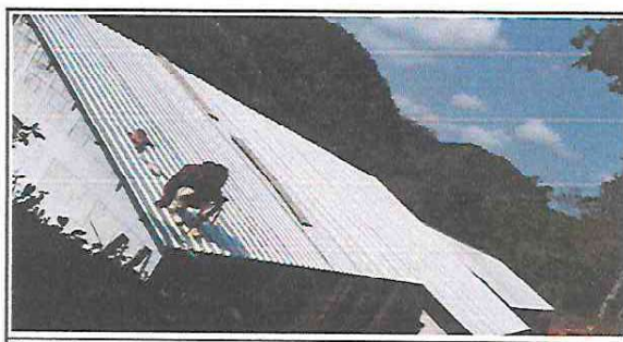
Foto 6: Se observa desde otro ángulo de como se quedó el techado.
