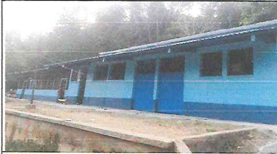
Foto 1: Se observa las nuevas puertas ya instaladas de las aulas.
