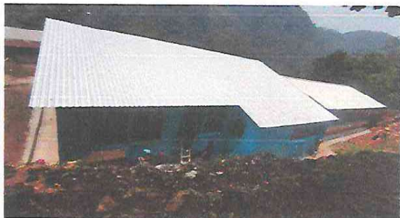
Foto 4: Se observa desde afuera de la escuela el cambio total del techo de la escuela con laminas nuevas.
